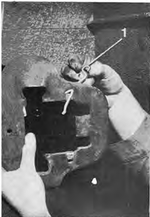
Mise en place du ressort d'appui. (Photo R.T.A.)
