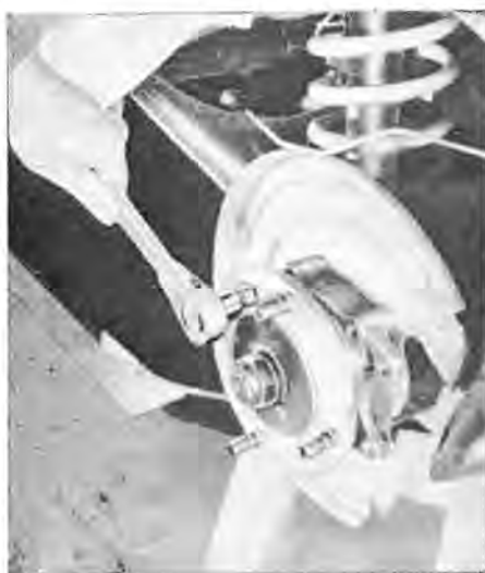
Dépose de la fixation de la fusée de sur le bras de suspension
